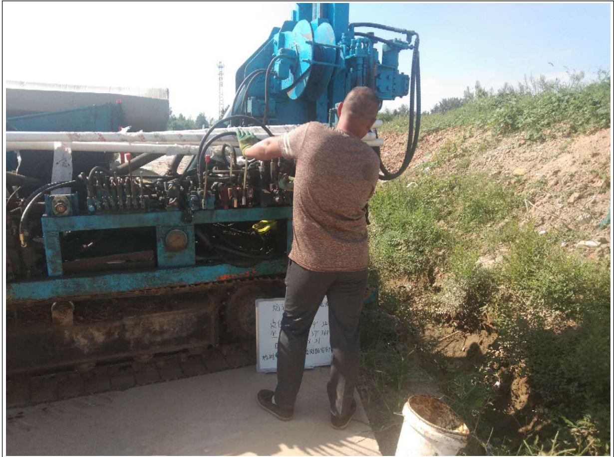
图 6.2-1 土壤取样、地下水建井设备照片
